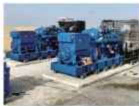
新疆轮台县天然气项目 A natural gas project in luntai, xinjiang
